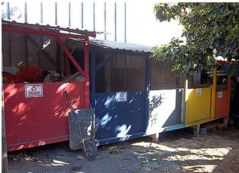
Figura 4. Baia fixa para acondicionamento de resíduos da construção civil.
