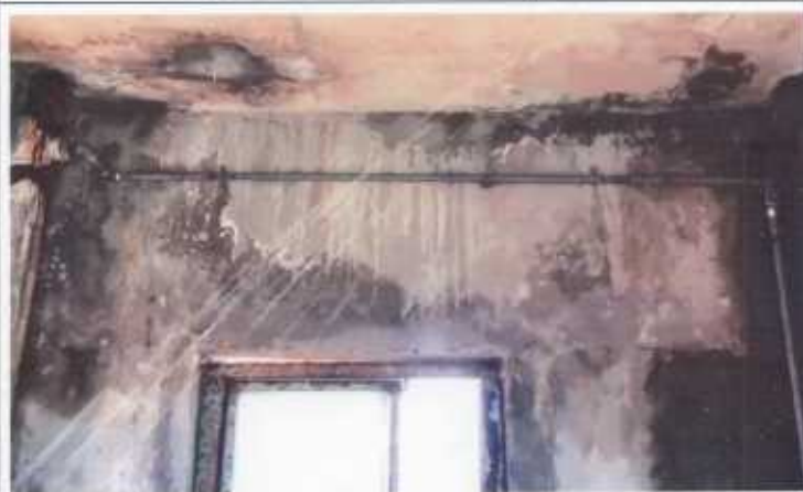
Laje de Fundo do Reservatório: Jorro de Água Constante
