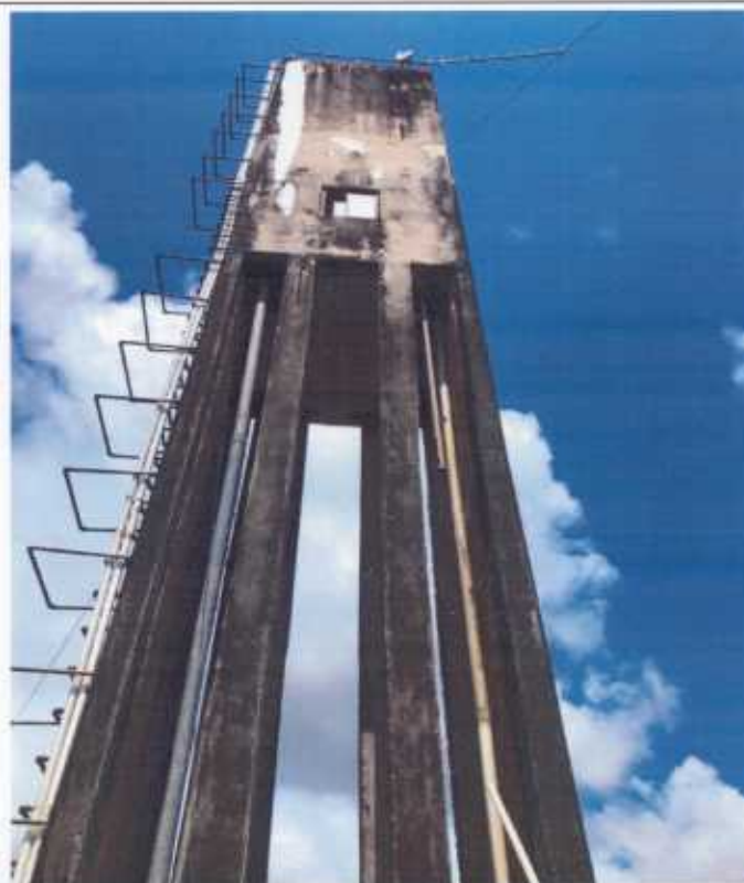
Face B – Fissuração e Mofo
