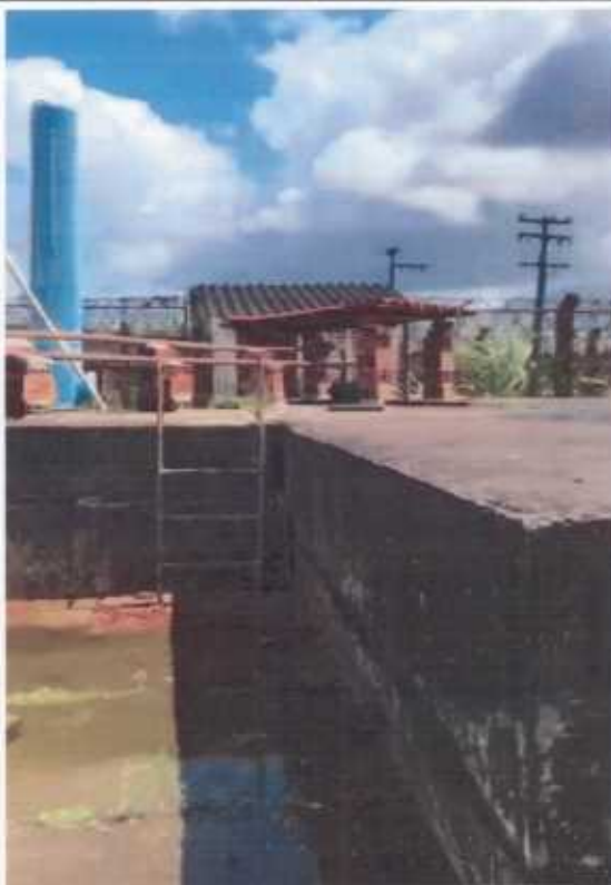
Casa de Bombas Improvisada sobre o Reservatório Inferior
