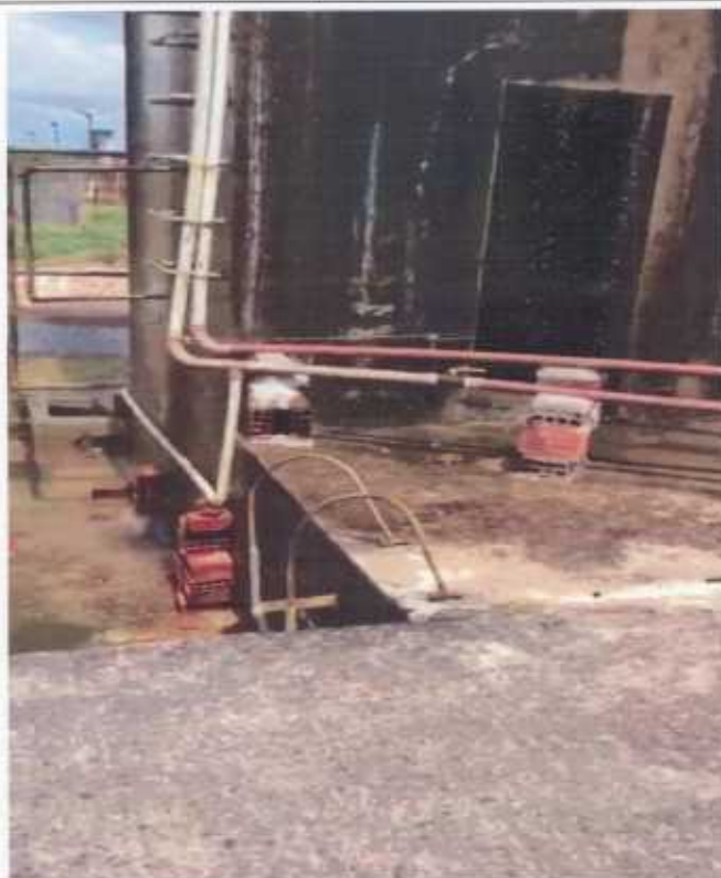
Tubulação Improvisada: Sucção e Recalque
