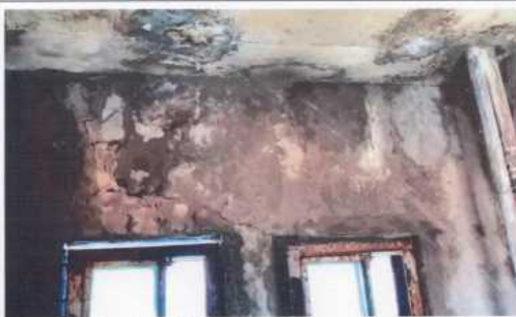
Quadro de Infiltrações Generalizadas
