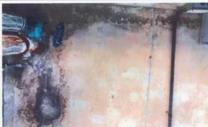
Ausência ou Falência de Impermeabilizações
