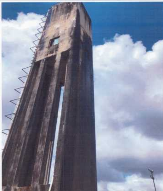
Faces B e C – Fissuração e Mofo
