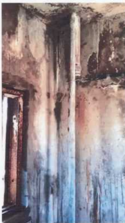
Buraco no Tubo: Escoamento Constante e Excessivo
