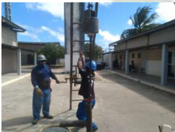
Foto 05 EXECUÇÃO DE SONDAGEM À PERCUSSÃO (SPT).
