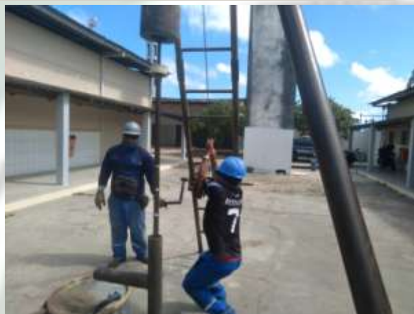
Foto 14 EXECUÇÃO DE SONDAGEM À PERCUSSÃO (SPT).
