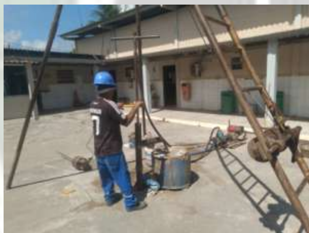
Foto 10 EXECUÇÃO DE SONDAGEM À PERCUSSÃO (SPT).
