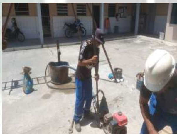
Foto 16 EXECUÇÃO DE SONDAGEM À PERCUSSÃO (SPT).
