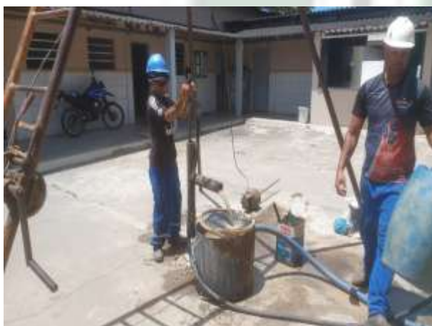
Foto 09 EXECUÇÃO DE SONDAGEM À PERCUSSÃO (SPT).
