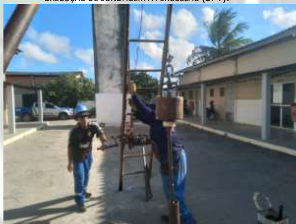
Foto 04 EXECUÇÃO DE SONDAGEM À PERCUSSÃO (SPT).
