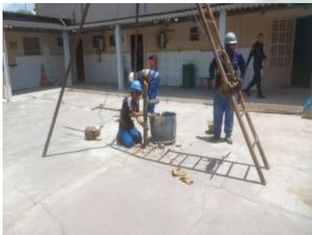
Foto 01 EXECUÇÃO DE SONDAGEM À PERCUSSÃO (SPT).
