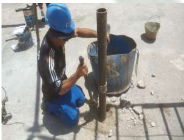
Foto 11 EXECUÇÃO DE SONDAGEM À PERCUSSÃO (SPT).
