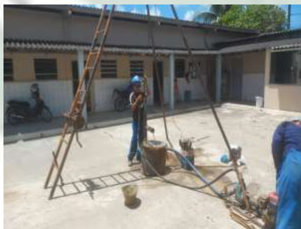
Foto 12 EXECUÇÃO DE SONDAGEM À PERCUSSÃO (SPT).
