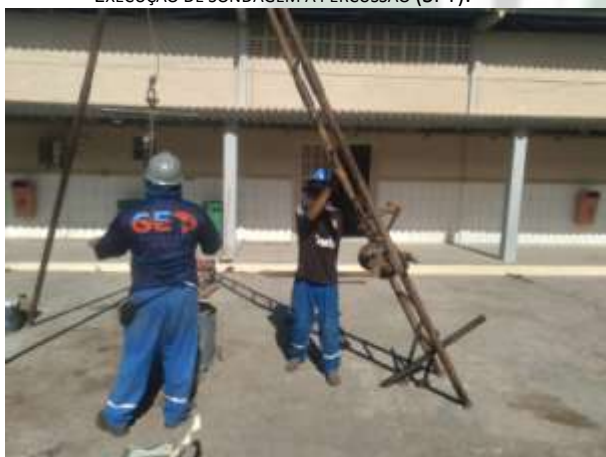
Foto 03 EXECUÇÃO DE SONDAGEM À PERCUSSÃO (SPT).
