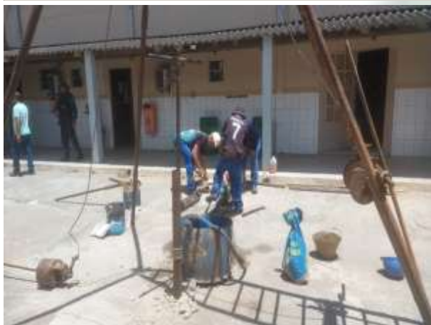
Foto 07 EXECUÇÃO DE SONDAGEM À PERCUSSÃO (SPT).
