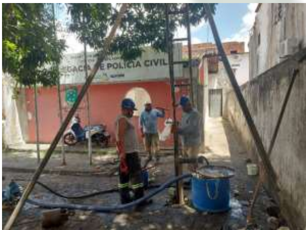
Foto 17 EXECUÇÃO DE SONDAGEM À PERCUSSÃO (SPT).
