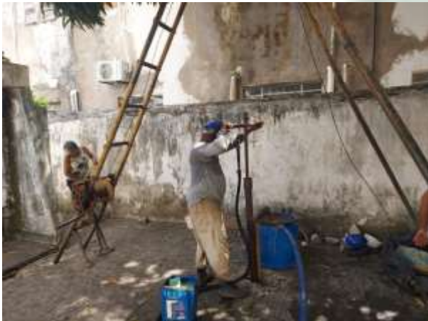
Foto 01 EXECUÇÃO DE SONDAGEM À PERCUSSÃO (SPT).
