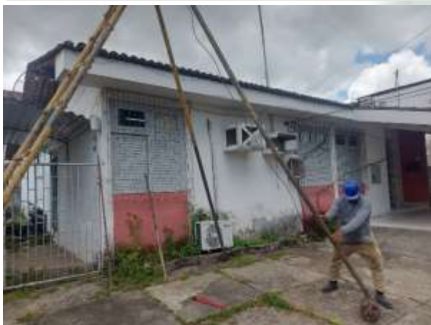
Foto 13 EXECUÇÃO DE SONDAGEM À PERCUSSÃO (SPT).
