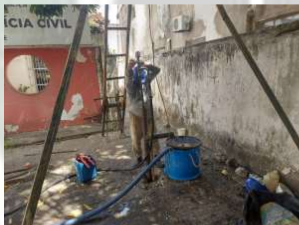
Foto 10 EXECUÇÃO DE SONDAGEM À PERCUSSÃO (SPT).
