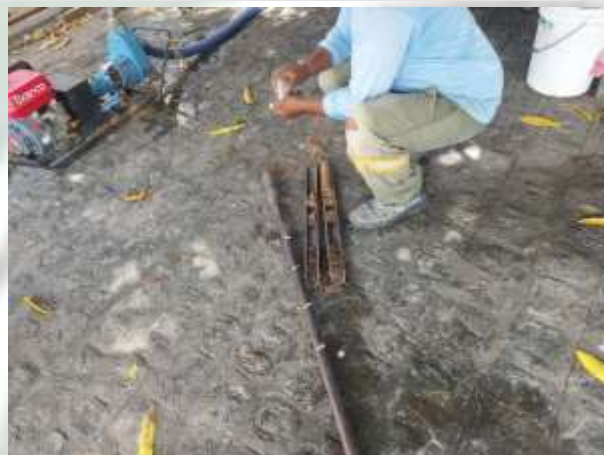
Foto 08 EXECUÇÃO DE SONDAGEM À PERCUSSÃO (SPT).
