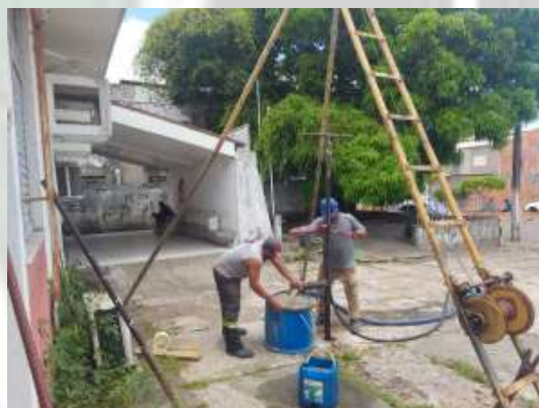
Foto 16 EXECUÇÃO DE SONDAGEM À PERCUSSÃO (SPT).
