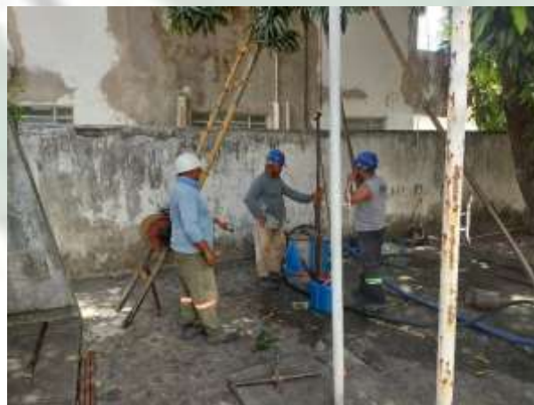
Foto 06 EXECUÇÃO DE SONDAGEM À PERCUSSÃO (SPT).
