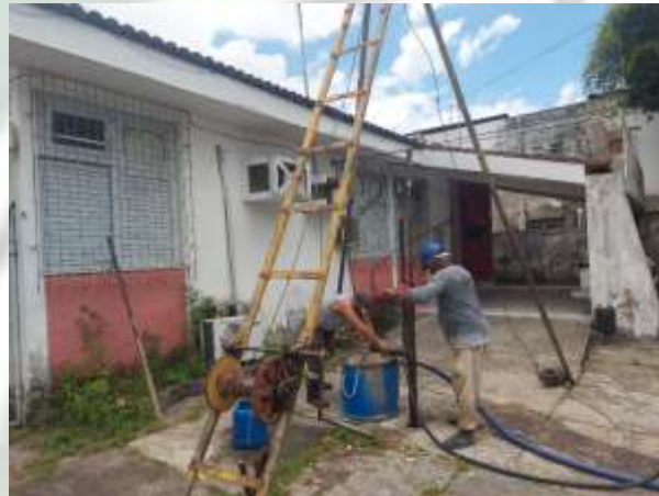
Foto 02 EXECUÇÃO DE SONDAGEM À PERCUSSÃO (SPT).
