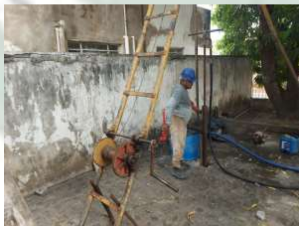
Foto 12 EXECUÇÃO DE SONDAGEM À PERCUSSÃO (SPT).
