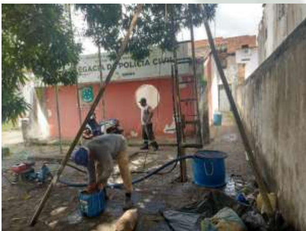
Foto 05 EXECUÇÃO DE SONDAGEM À PERCUSSÃO (SPT).
