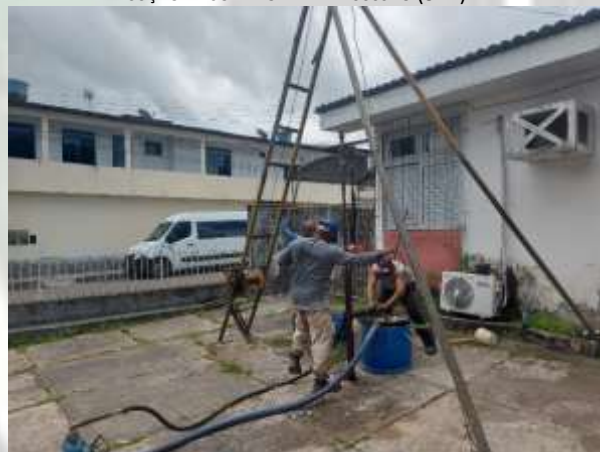
Foto 04 EXECUÇÃO DE SONDAGEM À PERCUSSÃO (SPT).
