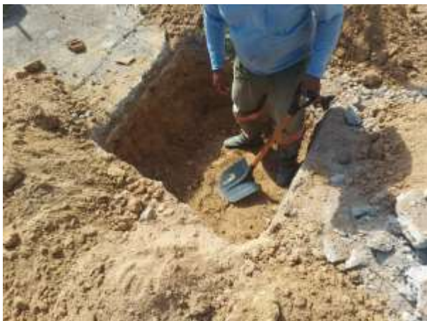
Foto 07 ESCAVAÇÃO DE JANELA PARA PERMEABILIDADE DE SOLO.
